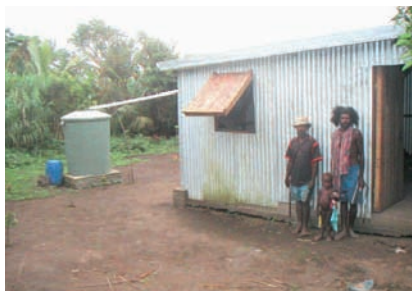
Nouvelle maison construite à Tanna, avec son tank d'eau de pluie
